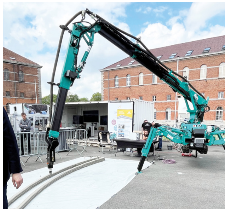
Uzņēmuma Constructions-3D betona drukas ierīce MaxiPrinter. Foto: Valters Lācis
