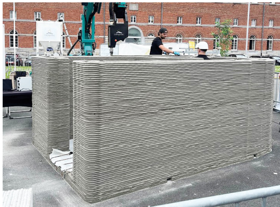
Uzņēmuma Constructions-3D betona drukas ierīces MaxiPrinter radītais nocietinājums Foto: Valters Lācis
